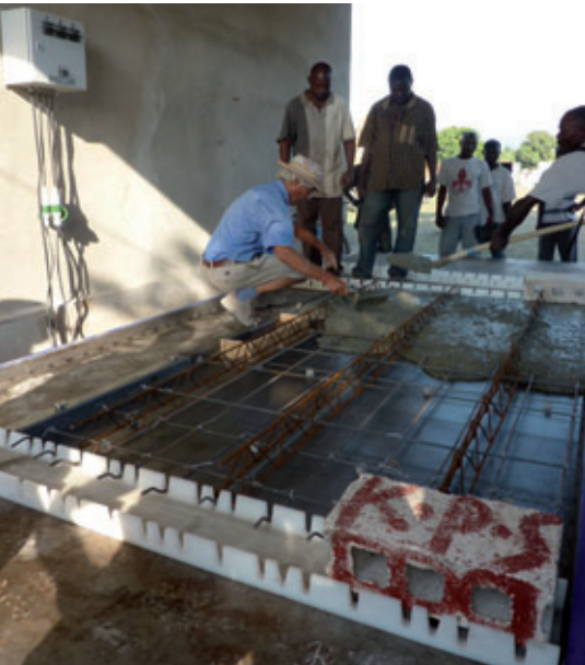
Sobre una mesa de producción estacionaria, suministrada por la empresa Weckenmann, de Alemania, se fabrican los forjados prefabricados (Fotos: Pro Haiti)
