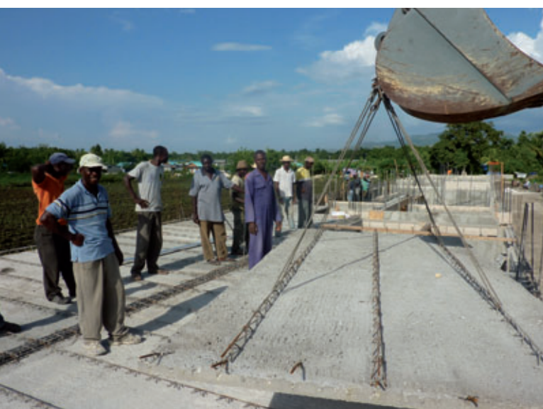
Los forjados prefabricados se transportan a la obra, allí se colocan y se hormigonan in situ con medios sencillos quedando listos (Fotos: Pro Haiti)
