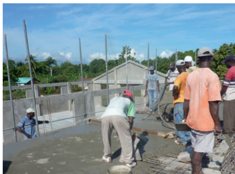
Los forjados prefabricados se transportan a la obra, allí se colocan y se hormigonan in situ con medios sencillos quedando listos (Fotos: Pro Haiti)
