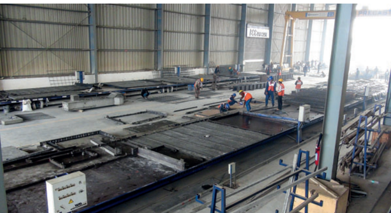
Production de prédalles et éléments spéciaux dans l'installation d'éléments préfabriqués en béton de Weckenmann à Bharat City, Inde.
