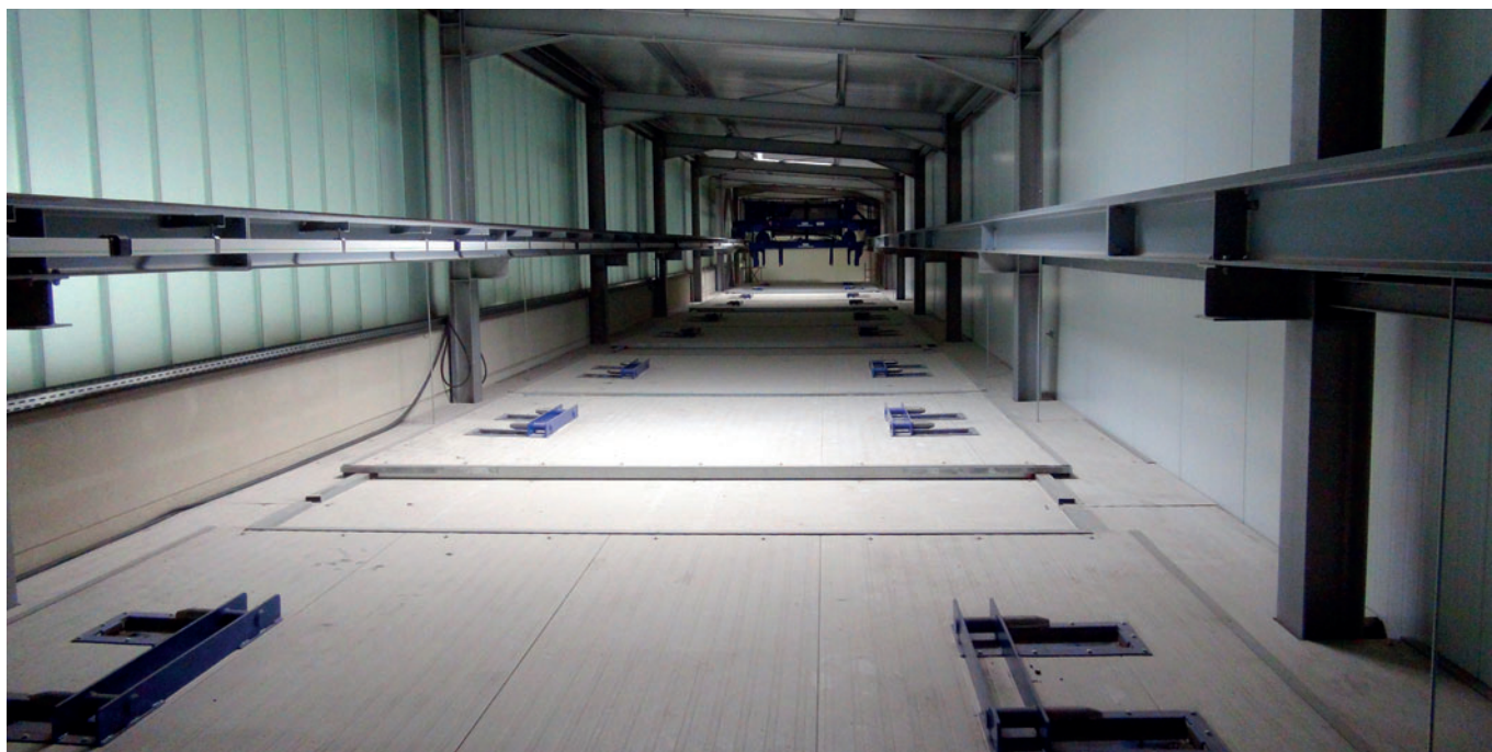
Vista de la nueva cámara de curado en Rail.One en Coswig.
