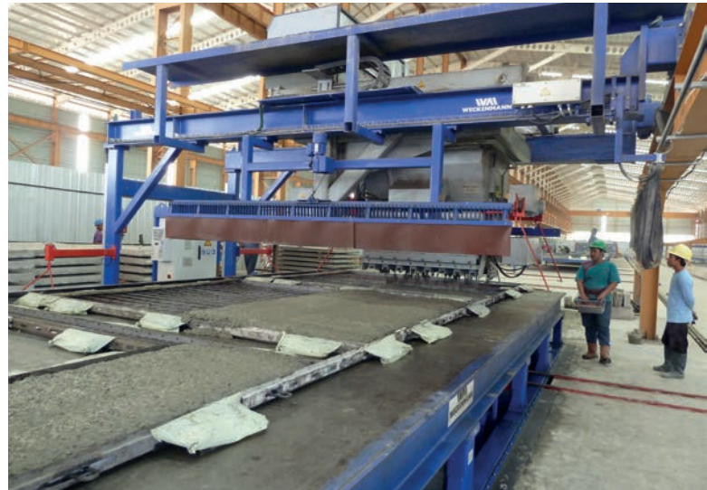
混凝土摊铺机在使用中
