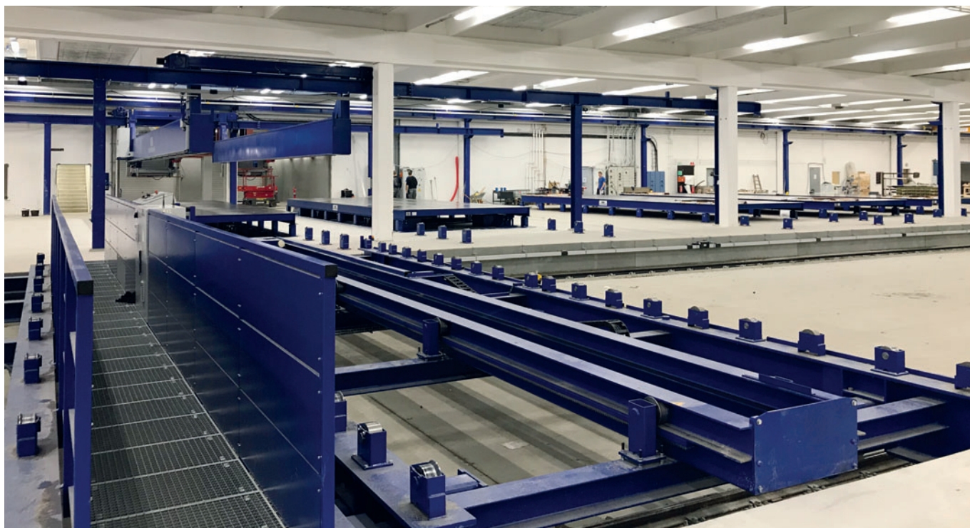
Zentrale Schiebebühne mit Doppelplattform
