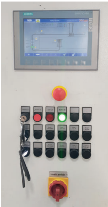
Pupitre de commande de communication pour la demande de béton, avec visualisation de processus
