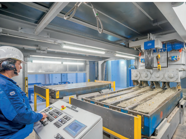
Poste de bétonnage
