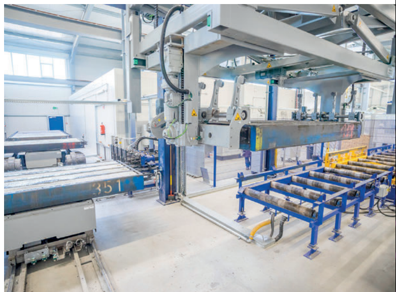
Poste de décoffrage
