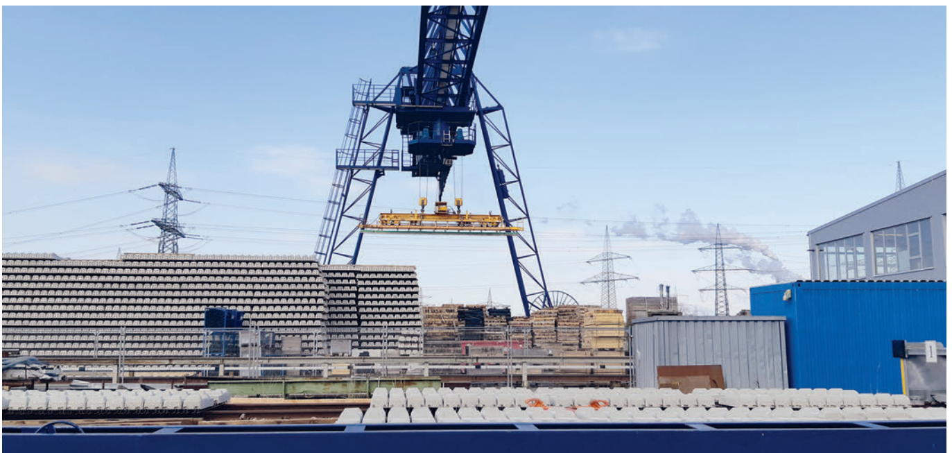
Aire de stockage des traverses en béton
