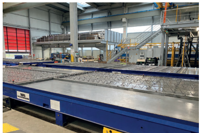
Weckenmann-Paletten (60 Paletten Lieferumfang, davon 12 Paletten mit Randschalungshöhe 60 mm und 48 Paletten mit Randschalungshöhe 70 mm) Einlegen von Bewehrung und Zubehör-Schalungspaletten mit A-Schalungen und integrierten Magneten
