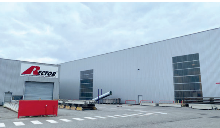
Neue Halle mit zweiter Umlaufanlage für die Doppel- und Elementdeckenfertigung
