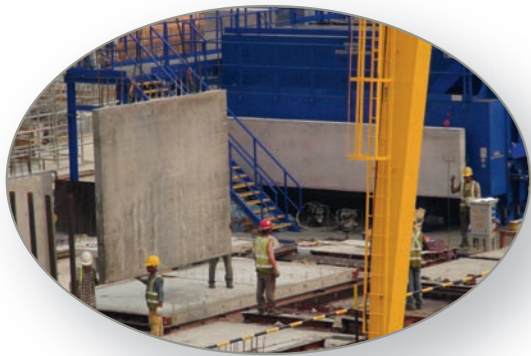
Ausheben der fertigen Wandelemente
