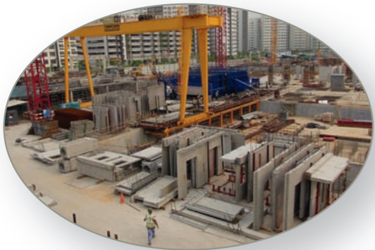
Baustelle mit Fertigteillager
