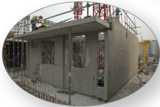
Fertig installierte Fertigteilwände
