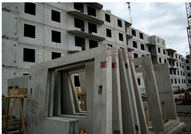
Новая технология домостроения ДСК «Блок», использующая однослойные несущие стены с теплоизоляцией, пришла на смену традиционной методике сэндвич-панелей
