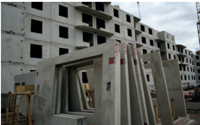
O novo sistema de construção de prédios da Blok substitui a construção sanduíche tradicional por um sistema em paredes estruturais e sistema térmico integrado
