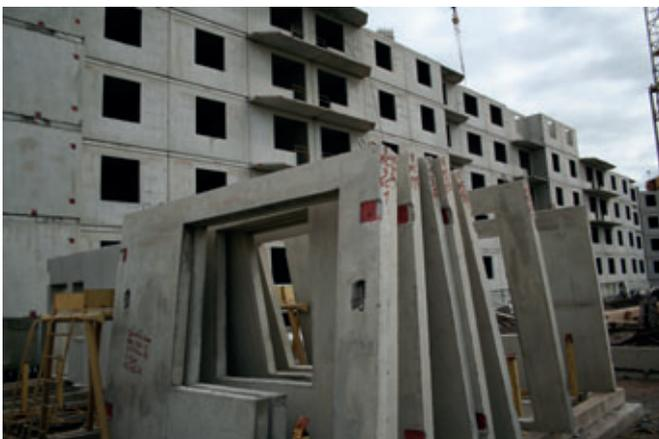
El nuevo sistema de construcción de viviendas de Blok sustituye la construcción sándwich tradicional por un sistema de muros portantes y sistema compuesto de aislamiento térmico
