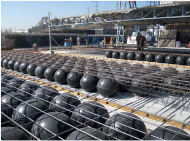
Avec sa nouvelle installation de production, l'entreprise mexicaine fabrique principalement des planchers alvéolés à résistance bi axiale, également appelés BubbleDeck en raison de leurs corps sphériques creux.
