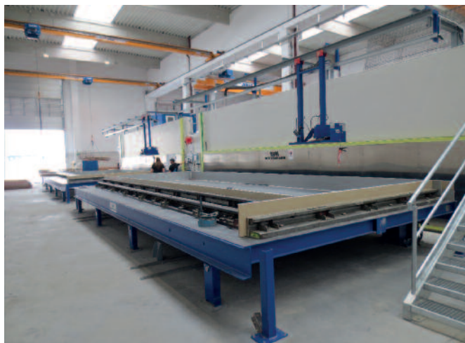
Опалубочная станция с лазерным проектором
