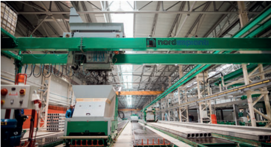
Fabricación de placas alveolares de Nordimpianti
