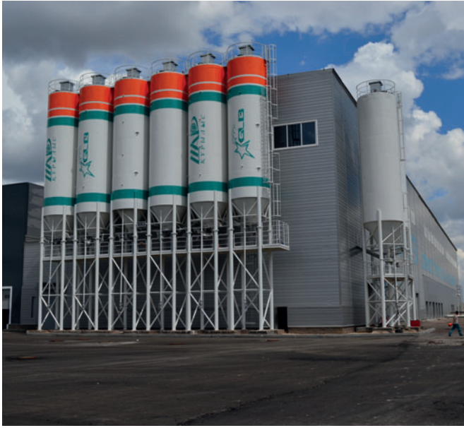
Teka Maschinenbau GmbH fue la encargada del suministro y el montaje de la instalación mezcladora de hormigón.
