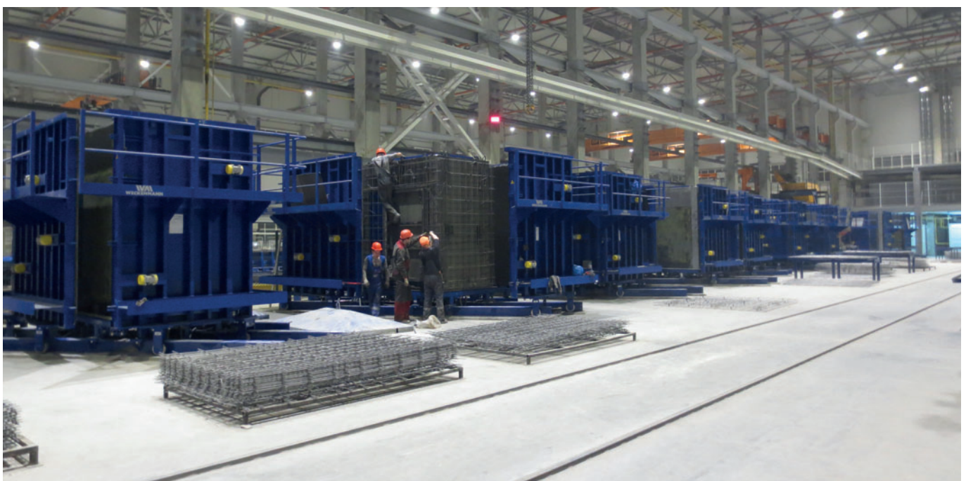
Liftschachtschalung in Reihe
